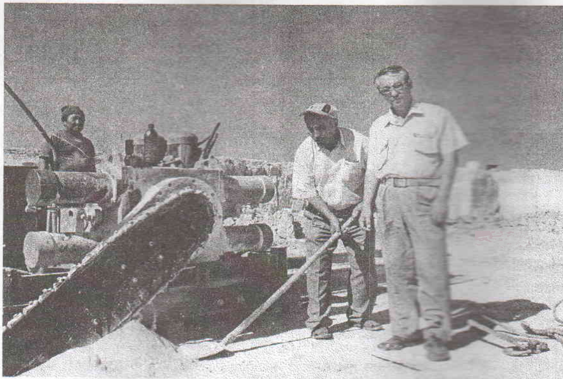
Рис.3. Добыча блоков известняка-ракушечника на карьере «Сары-Таш» баровой камнерезной машиной «Виктория» (Россия)
